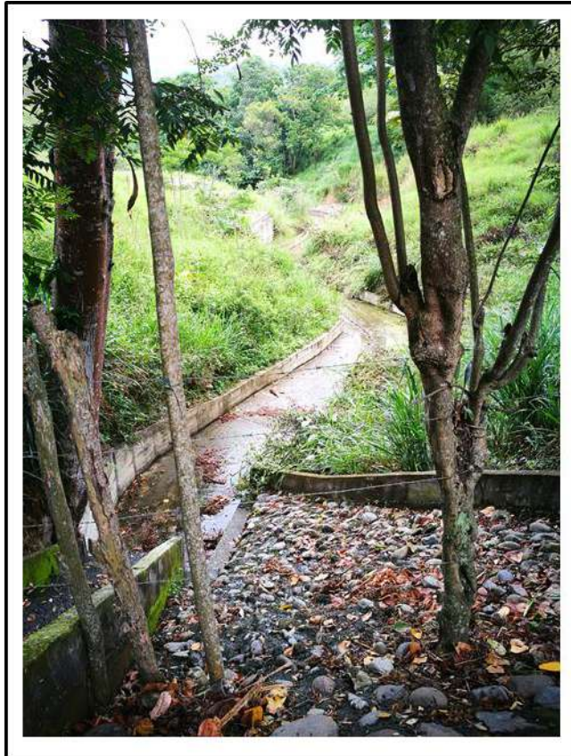
Ilustración 57. Obras de manejo de aguas de escorrentía, sector Piedras de Moler. Elaboración propia.
