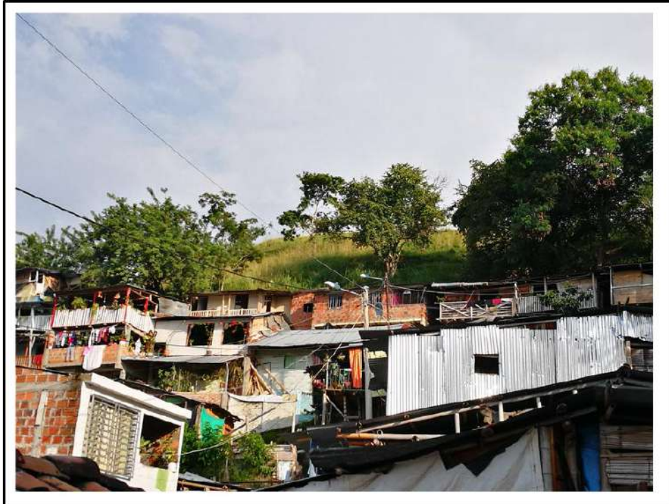
Ilustración 37. Asentamientos subnormales en zona de altas pendientes en el barrio Robert Tulio Lora. Elaboración propia.
