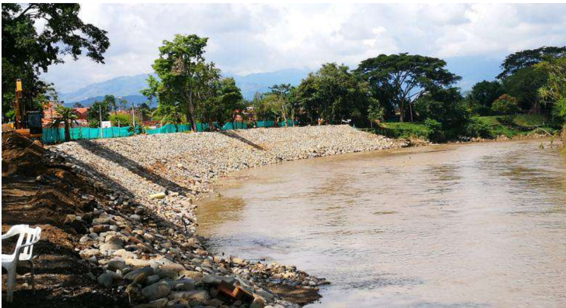
Ilustración 96. Construcción obra de reducción del riesgo por inundación y socavación lateral de cauce del río La Vieja. Propia, 2019.
