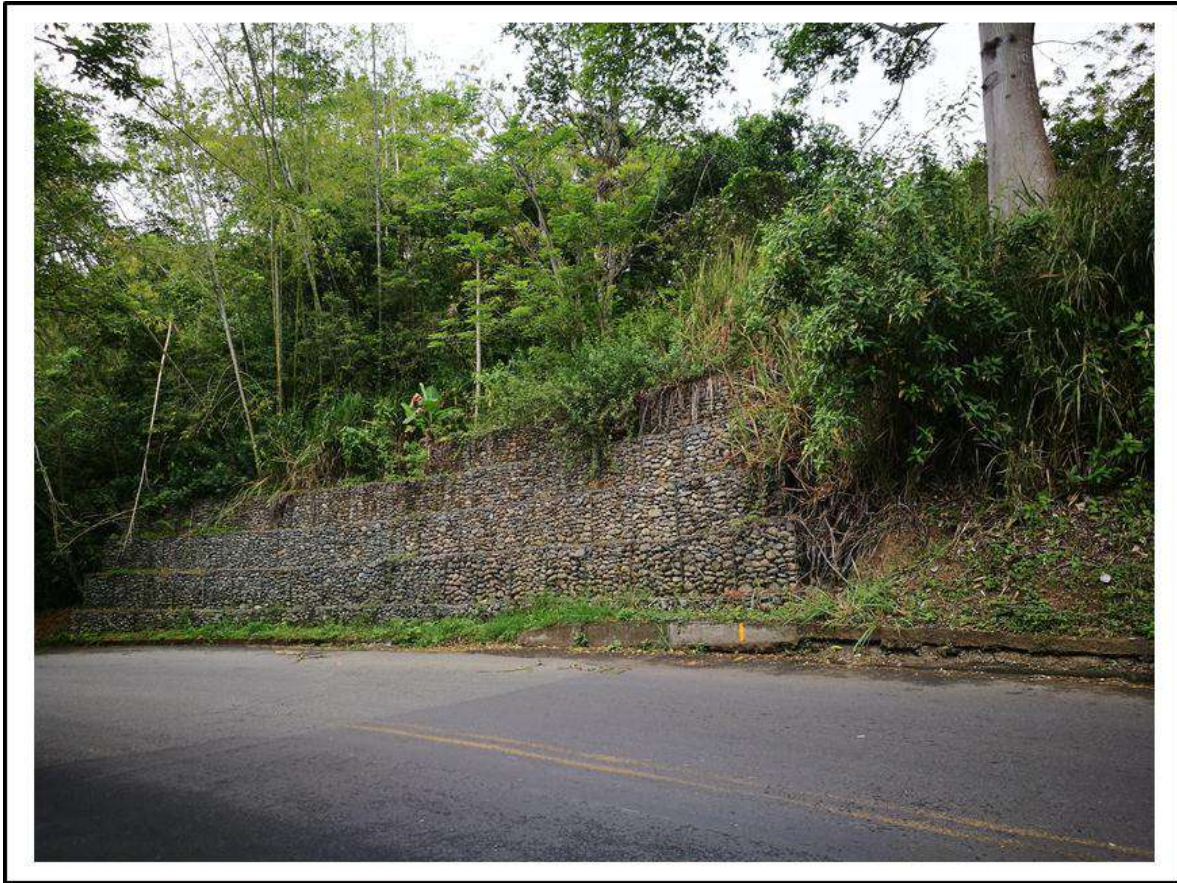
Ilustración 56. Obras de mitigación realizadas en el sector de Piedras de Moler. Elaboración propia.
