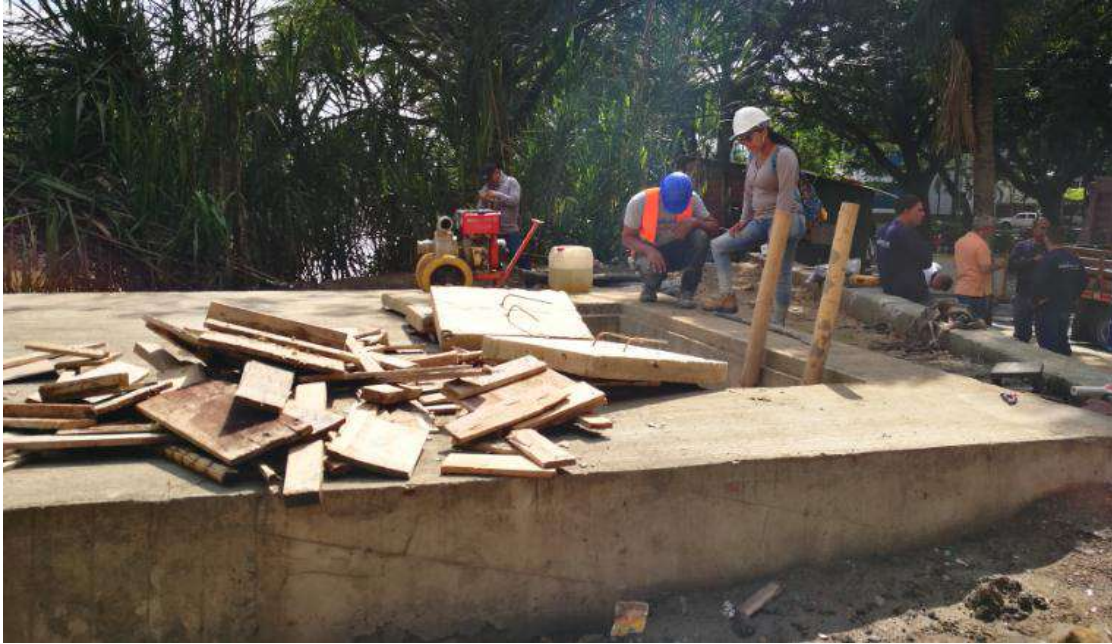
Ilustración 95. Construcción de motobomba en el sector El Prado. Elaboración Propia, 2019.
