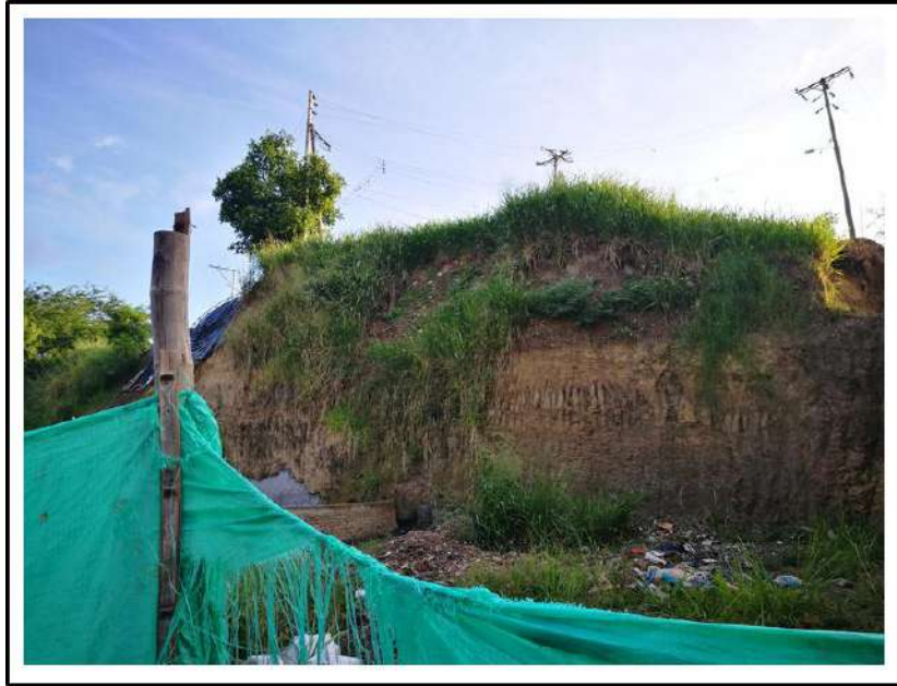
Ilustración 30. Talud en el barrio Conquistadores. Elaboración propia.
